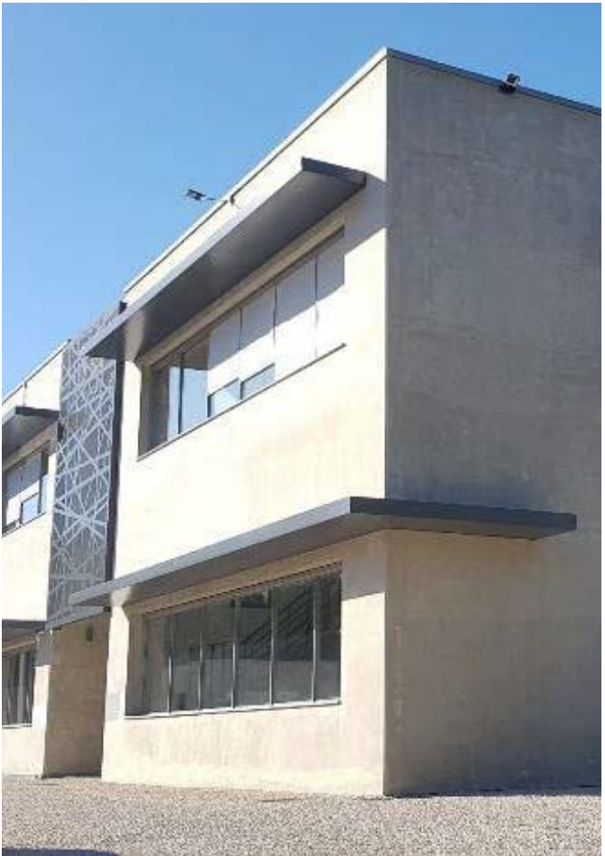
Bureau et Ateliers - High Taix | Bepos Effinergie 2013 | MO : High Taix | Archigraph | Gardanne (13)
