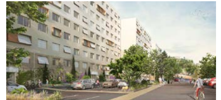
Résidence Les Jonquilles | BBC-Effinergie rénovation 2021 | MO : Villogia Marseille | Avant-Propos Architecte | Marseille (13)
