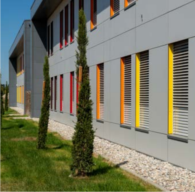
La Bureaux Cheyenne et Aztec | Bepos Effinergie 2017 | MO : SARL Pipper | Apside architecture S | Avignon (84)
