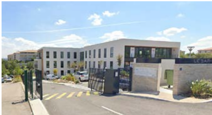
Le Saphir | Bepos Effinergie 2013 | MO : Arteprom | Agence VBI | Aix en Provence (13)
