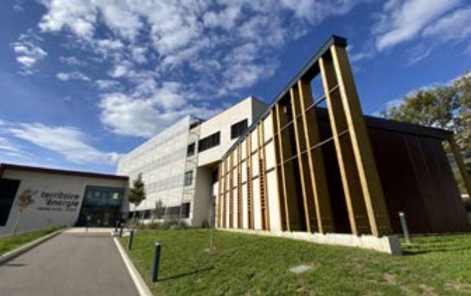
Siège du SYMEnergie 05 | Bepos Effinergie 2017 | MO : SYMEnergie 05 | Agence Blay & Coulet et Solea Voutier et Associés Architectes | Chorges (05)
