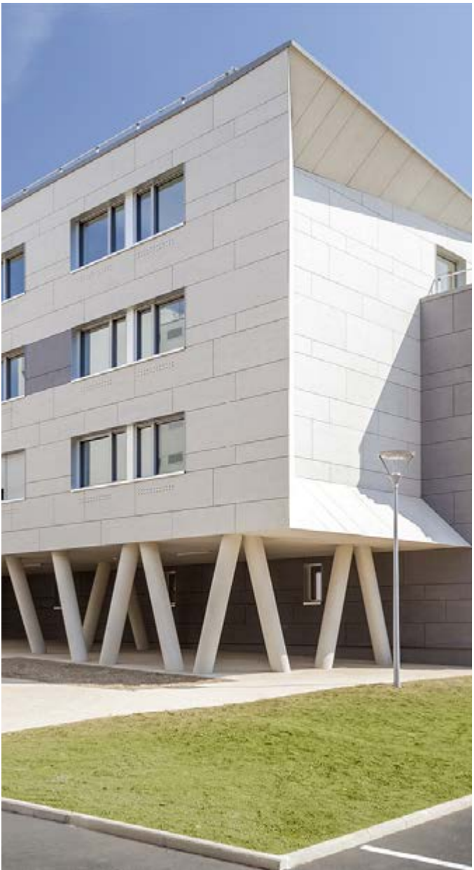
Résidence étudiante Arc en Meyran | Bepos Effinergie 2013 | MO : Crous Aix Marseille | A+ Architecture | Aix-en-Provence (13)
