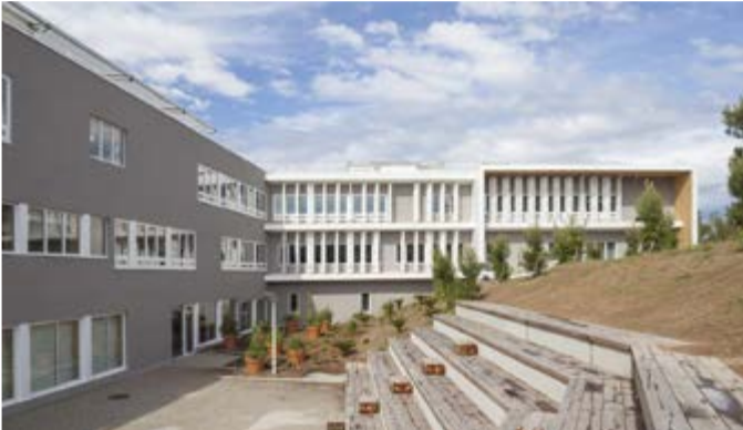
Logement de fonction du collège de l'Estérel | Effinergie+ | MO : Conseil Général du Var | BBG Architectes | Saint Raphaël (83)
